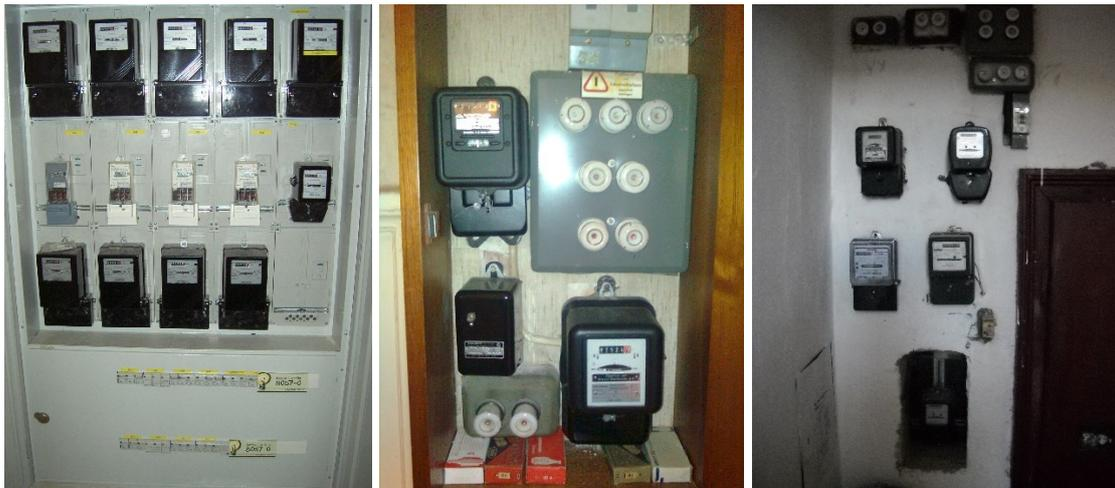
Abbildung 4: Darstellung unterschiedlicher Zählplätze im Netzgebiet. Zähler montiert in einem modernen Zählerschrank auf Normzählertafeln (links); Zähler in ein Möbel eingebaut (Mitte); aufputz montierte Zähler (rechts), Quelle: Eigene Darstellung.
