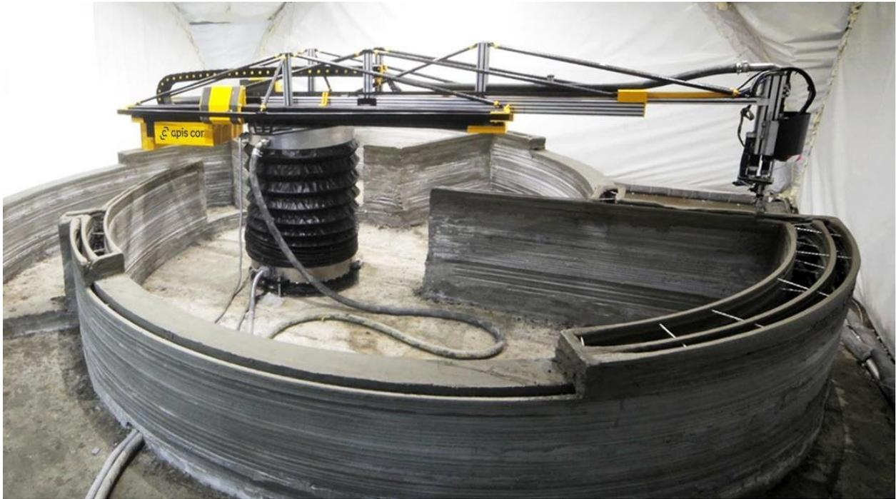
Abbildung 25: Apis Core 3D-gedrucktes Haus, Quelle: Quartz Media (2020), Onlinequelle [06.10.2020].
