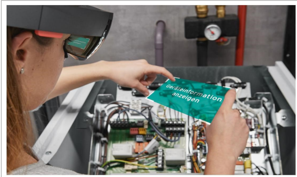
Abbildung 13: Augmented Reality basierte Unterstützung für das Lernen im Sanitär-Heizung-Klima-Handwerk 1 (ARSUL, 2018, S. 4)
