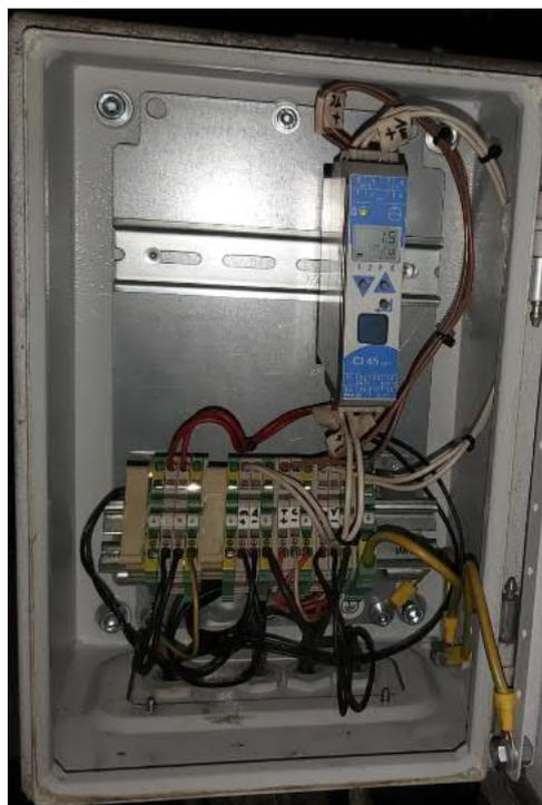
Abbildung 26: Aufbau Messumformer, Quelle: Eigene Darstellung.
