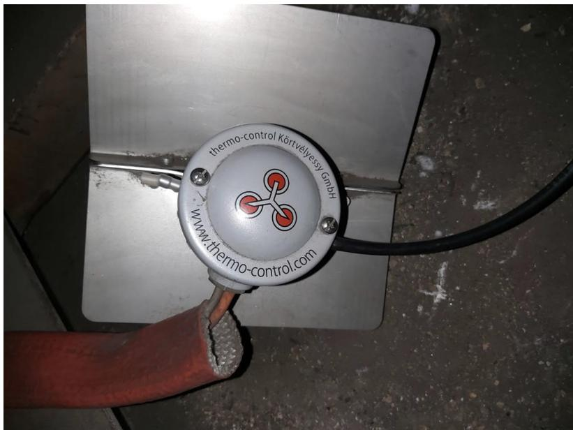
Abbildung 25: Eingebaute Sauerstoffsonde mit Spülungen und Hitzeschutzblech, Quelle: Eigene Darstellung.
