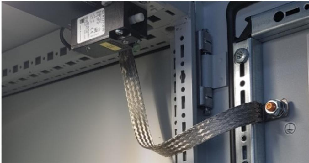
Abb. 22: HF-Masseband zwischen Rahmen und Tür, Quelle: Eigene Darstellung.
