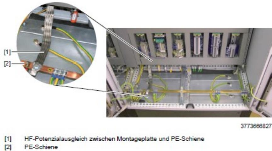
Abb. 41: HF-Potenzialausgleich zwischen Montageplatte und PE-Schiene, Quelle: SEW-EURODRIVE GmbH & Co KG (2013), Online-Quelle [22.08.2018], S. 43.
